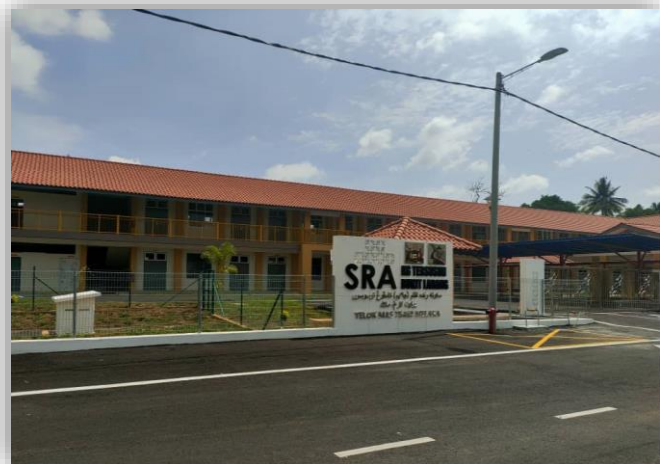
Projek SRA Bukit Lintang yang telah siap dibangunkan
