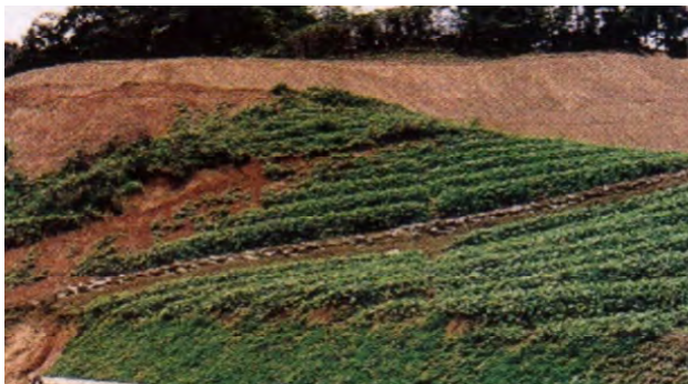
Pembangunan di atas bukit
