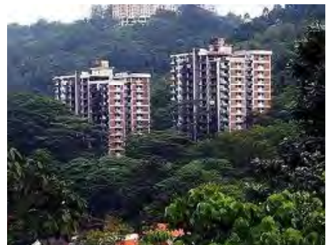
Pembinaan bangunan di atas tanah tinggi
