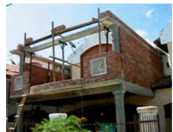
Kerja tambahan bangunan kediaman yang melibatkan tambahan luas lantai
