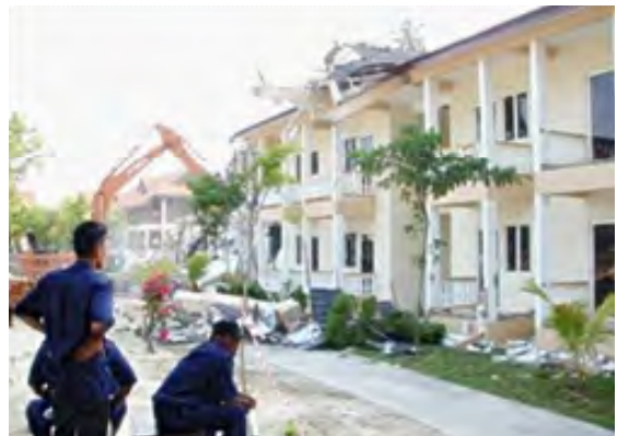
Pemantauan kerja perobohan bangunan oleh penguatkuasa
