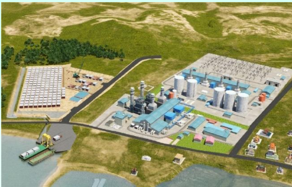
Melaka Power Plant, Kuala Sungai Baru Sumber : HSL Constructor Pte Ltd
